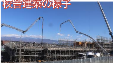
校舎建築の様子
